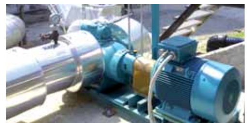
6 Pompa do obiegu bituminu L2NG
